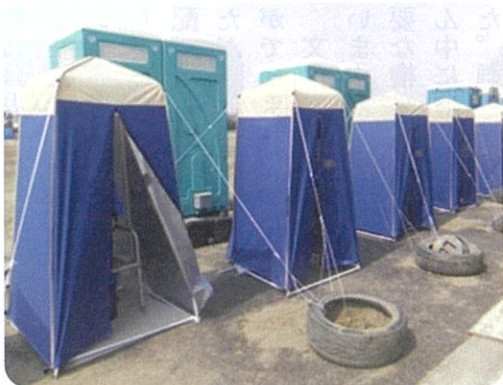
写真2 手前・マンホールトイレと後方・仮設トイレ、国土交通省HP
